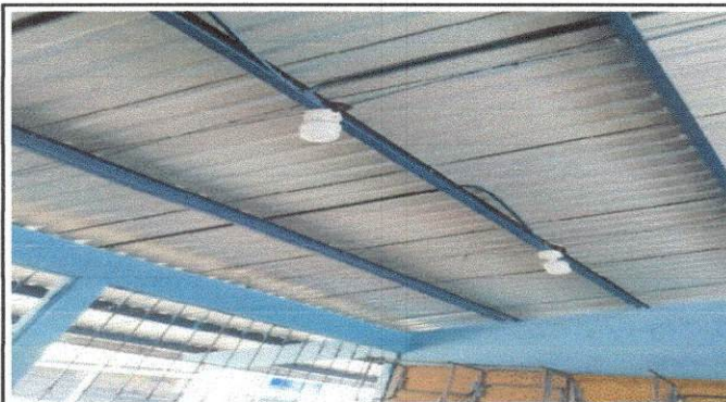
Foto 3: Aquí podemos observar ya el trabajo frinalizado de la reparación del cableado electrico y la colocación de nuevas lamparas para la iluminación del establecimiento.
