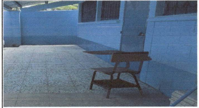
Foto 8: La parte del piso quedo ya lista para ser utilizado.
