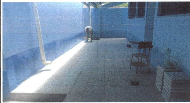
Foto7: Aquí se puede apreciar que la instalación del piso granito a quedado terminada.
