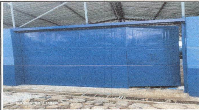
Foto 1: Aquí podemos observar como quedo el porton principal de la escuela en la parte del frente.
