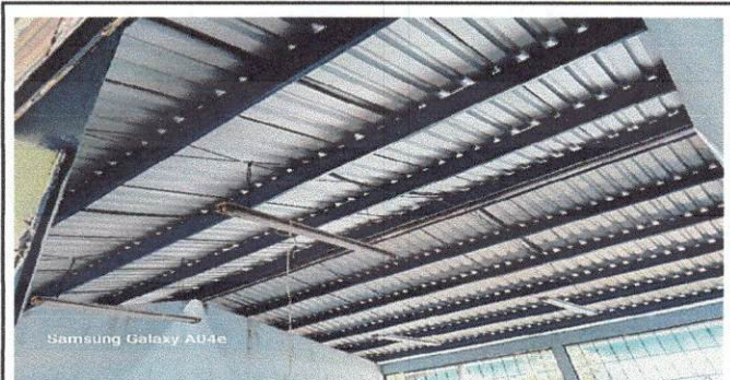
Foto 5: Podemos ver aquí como quedo el techo ya cambiado todo bien instalado para evitar filtraciones de agua.
