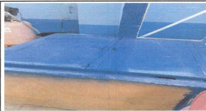
Foto 11: La tapadera del pozo ya esta restaurada se ve como nueva.
