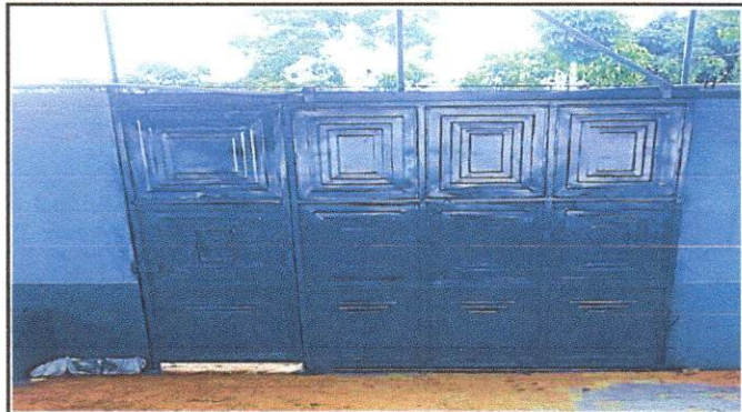
Foto 2: Aquí podemos observar como se ve el porton despues de la reparación por la parte de atrás. Habra mas seguridad para nuestros estudiantes y para el resguardo del mobiliario del establecimiento.
